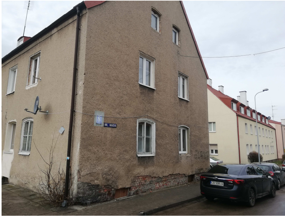
Zdj. nr 3 Widok elewacji wschodniej
