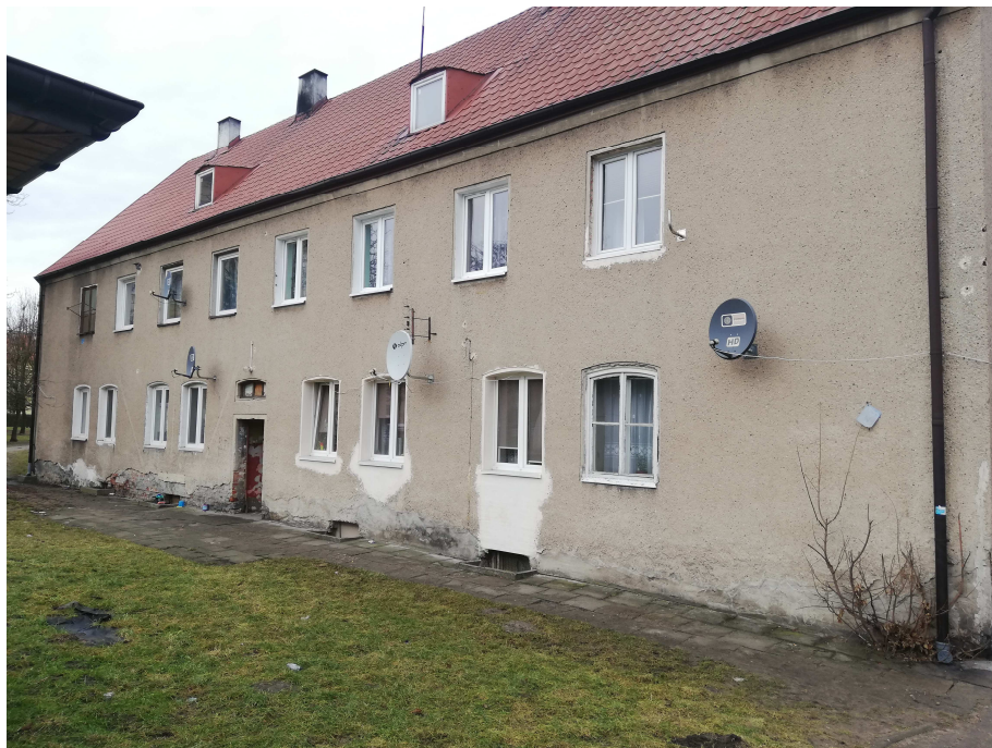
Zdj. nr 1 Widok elewacji południowej
