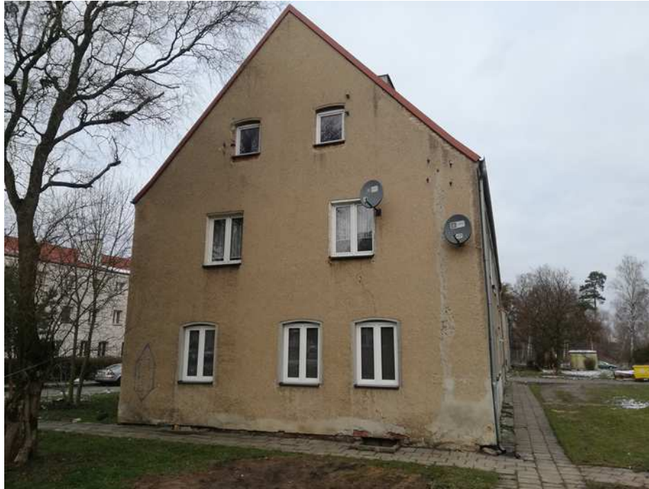
Zdj. nr 3 Widok elewacji południowej. Przed przystąpieniem do prac dociepleniowych należy naprawić zarysowanie ściany.
